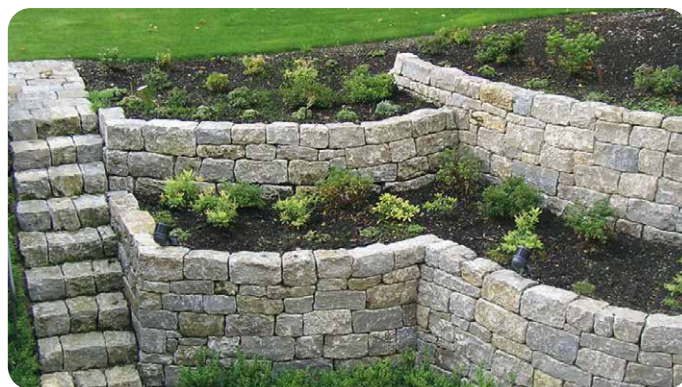
Schichtmauerwerk, 12.3
