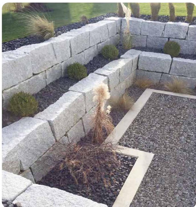
Mauersteine Granit, 11.15 und 11.17
